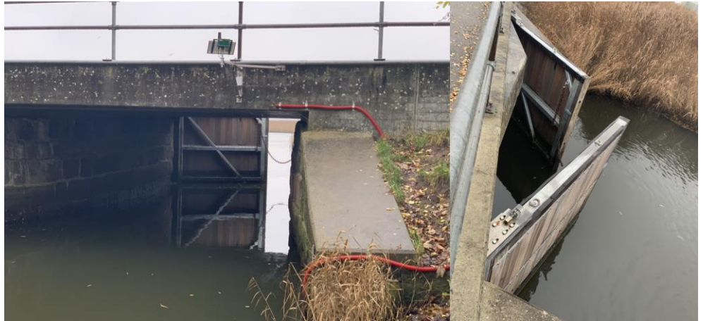
Figur 2-10 Slusen ved Tubæk Å's udløb under Østerbro. 15. november 2024, Peter F. Klagenberg, COWI.
